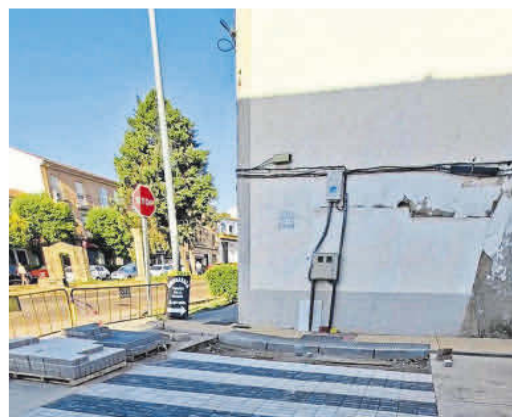
Estado de las obras.
