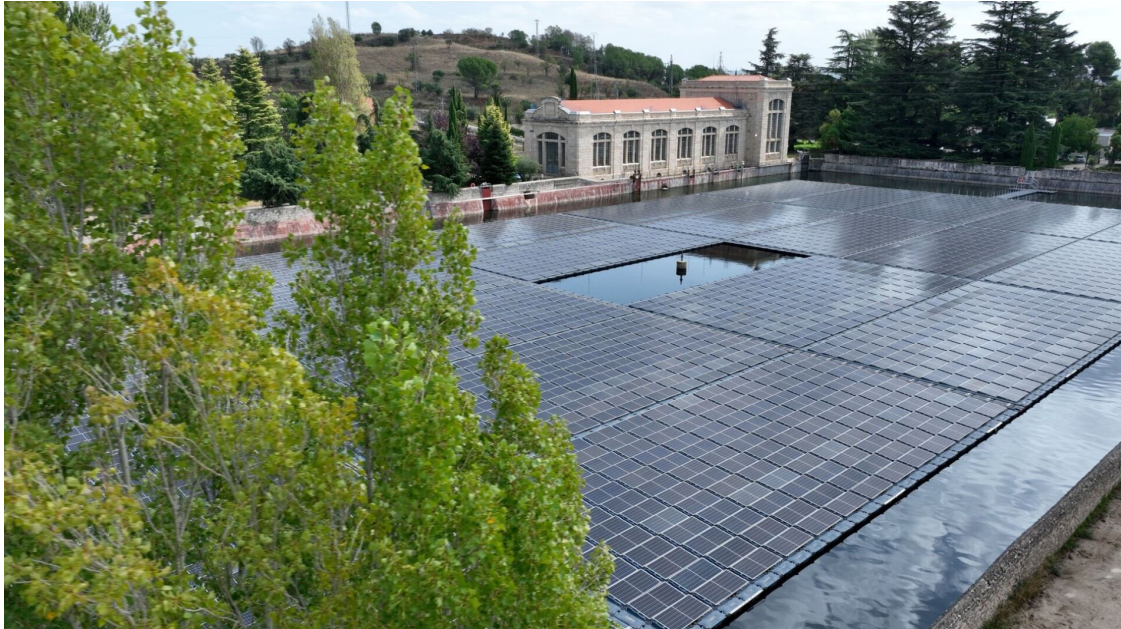
El Canal de Isabel II suma nueve plantas fotovoltaicas y aumenta hasta el 86% su capacidad de autosuficiencia energética
